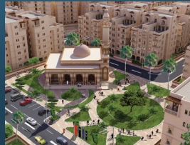
إنشاء المشاريع السكنية والتجارية
